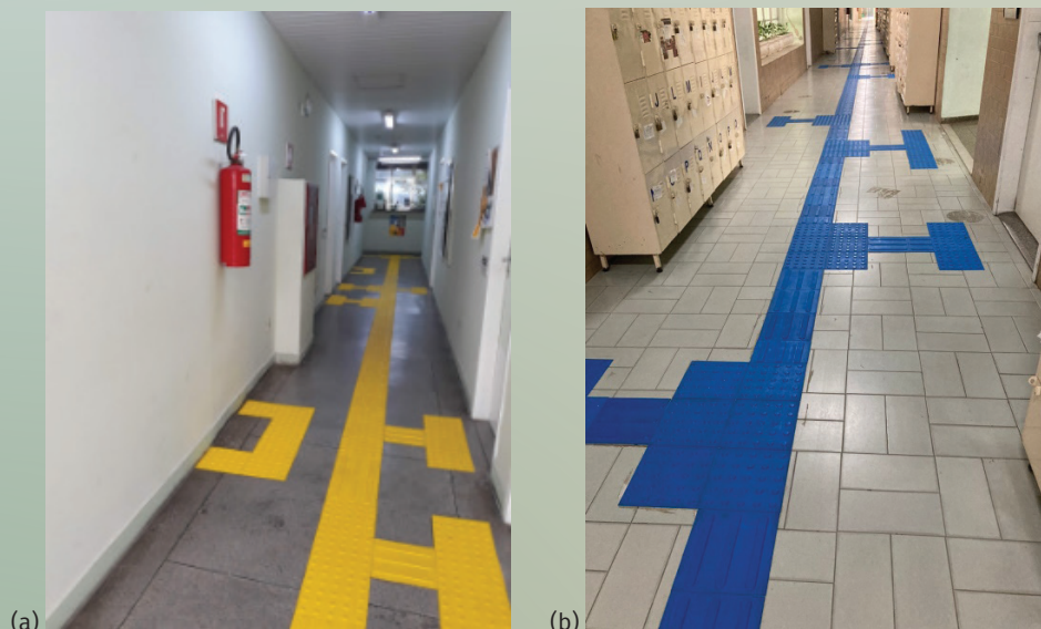
Figura 4.13: (a) Piso tátil no campus Campos Guarus; (b) Piso tátil no campus Campos Centro
